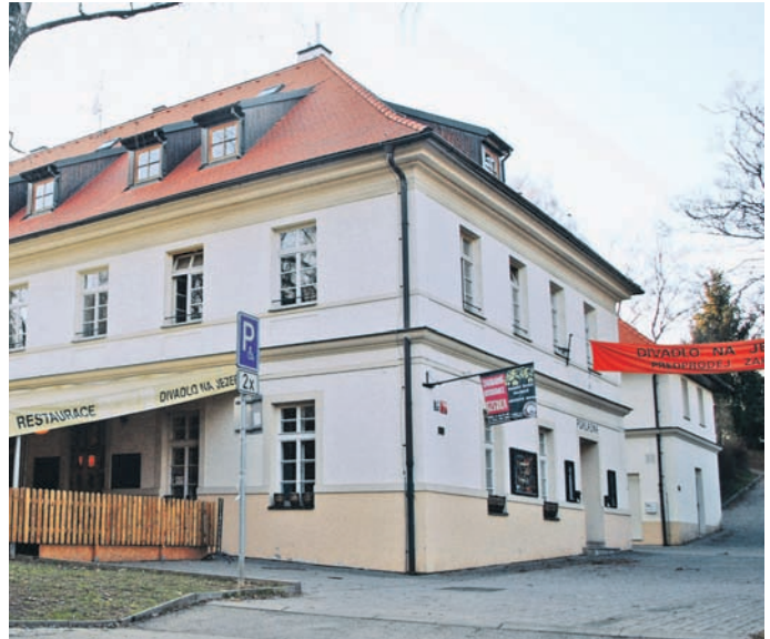
Budova Divadla Na Jezerce.
